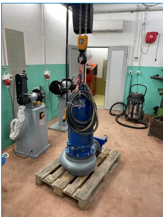
Revision der Kühlwasserpumpen
