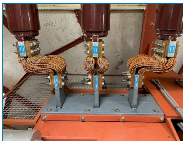
Thermostrips auf den Statorabgängen der Maschinengruppe 2
