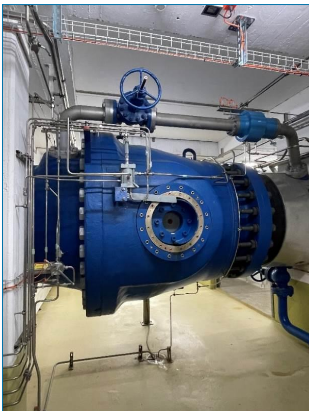
Kugelschieber Maschinengruppe 2
